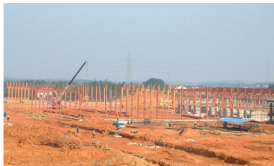
2005 年，湖北奥瑞金制罐有限公司兴建现场
